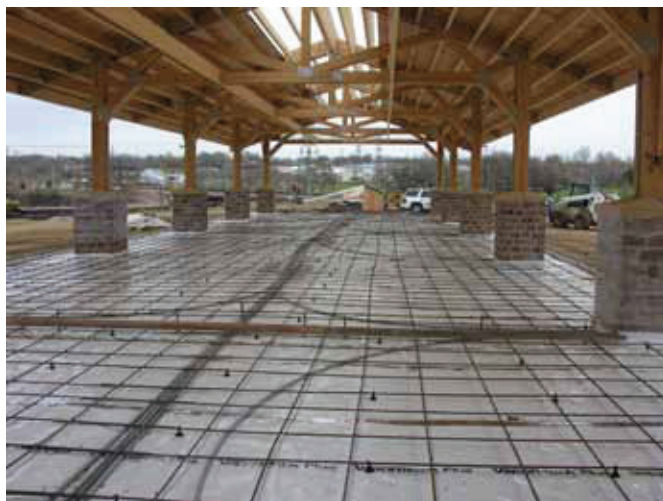
Under-Slab Vapour/Gas Retarder
